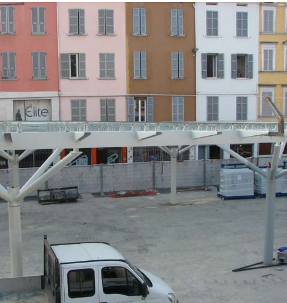
Il cantiere di Piazza Ghiaia. Dopo 3 anni di chiusura, da dicembre 2010 la piazza è riaperta al commercio e al pubblico
